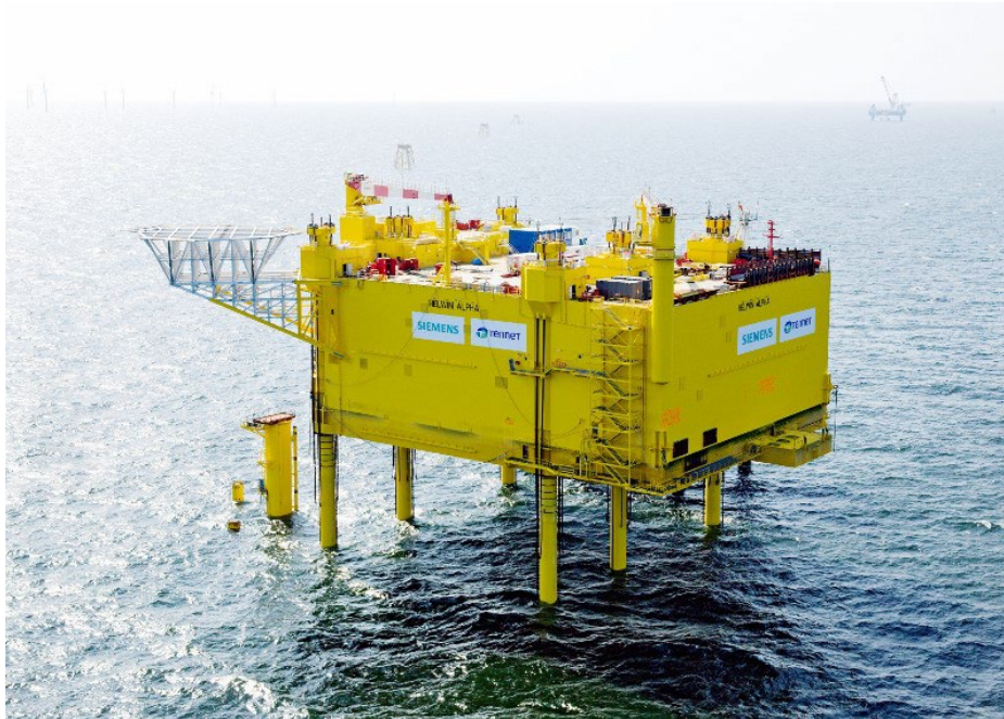
Kuva 2-8. HVDC HelWin Alpha, esimerkki itseasentuvasta asemasta, joka hinataan paikalleen ja nostetaan ylös nostojalkojen avulla. Lähde: www.overdick-offshore.com .
