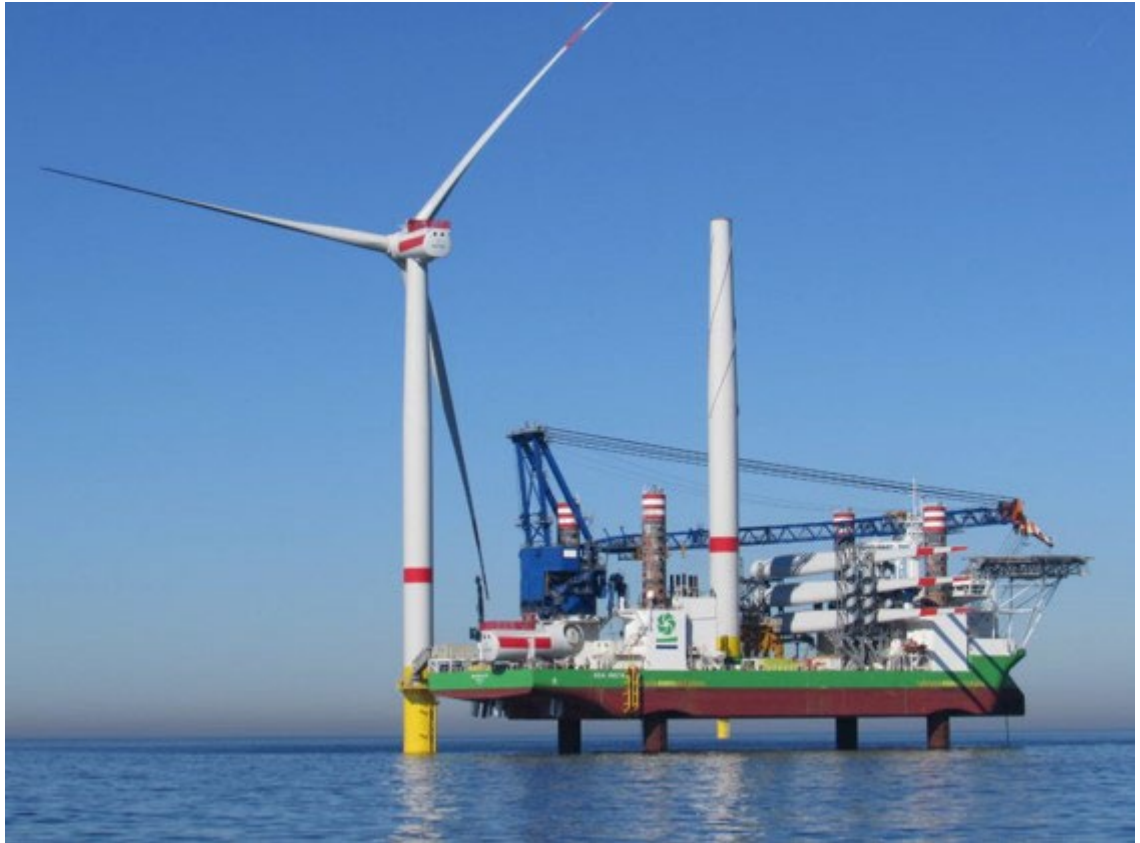
Kuva 1-10. Merituulivoimalan asennus jack-up aluksella (kuva: COWI).
