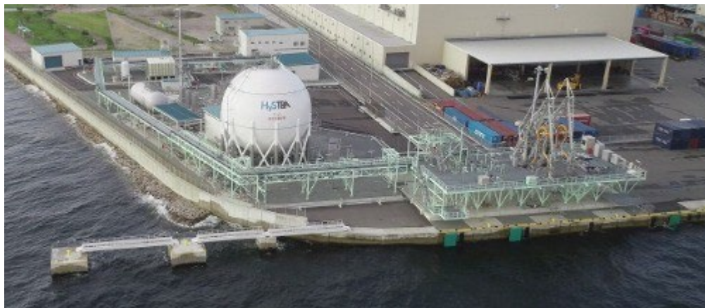
Kuva 2-12. Kuva vedyn varastoinnista nestemäisessä muodossa.
