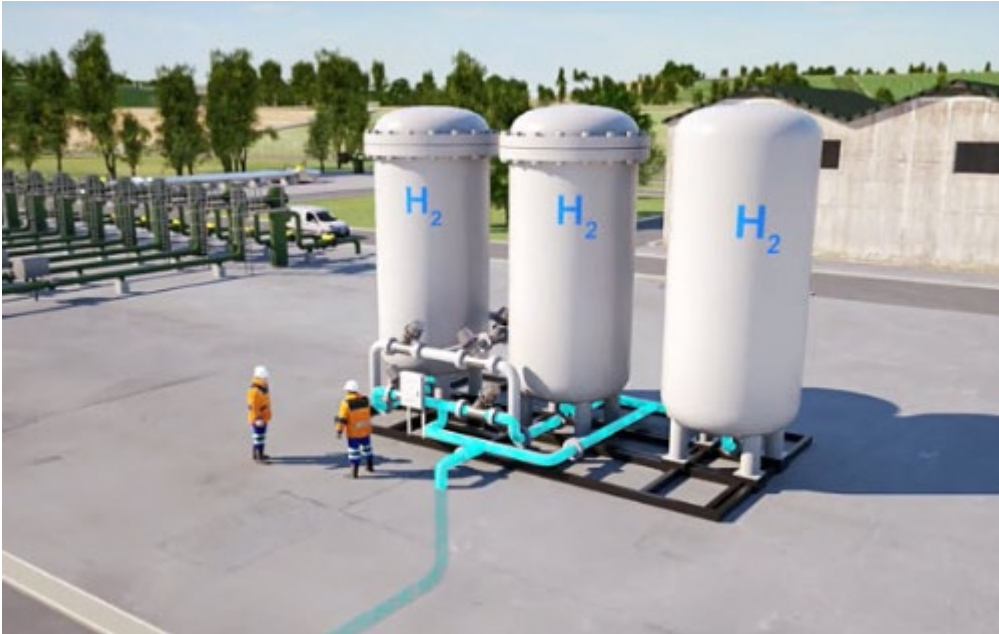
Kuva 2-10. Esimerkki paineistetuista varastosäiliöistä vedyn varastointia varten. Lähde:: Hybrit.
