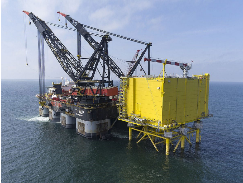
Kuva 2-7. HVDC DolWin Alpha, esimerkki asemasta, jossa on ristikkoperustus. Nosturialuksen nostokapasiteetti on noin 22 000 tonnia. Lähde: www.overdick-offshore.com .
